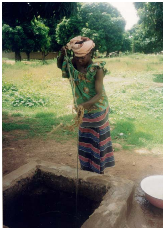
Puits pour l'approvisionnement en eau potable (© Bound8/DR).
