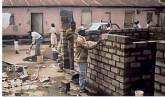
Hình 6: Thị trấn xây dựng ở Kenya đang xây dựng nhà cho thuê bằng gạch đất nung
