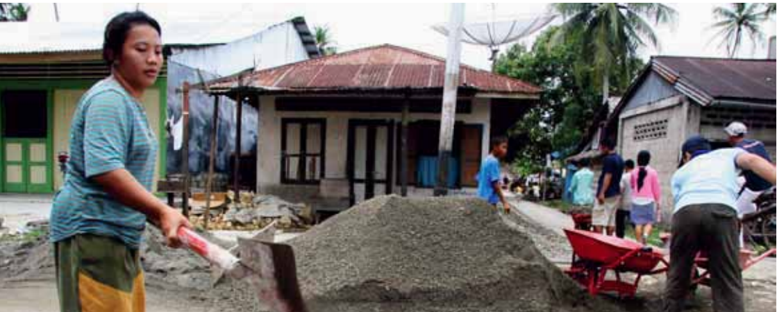
Tự giúp đỡ lẫn nhau xây dựng nhà cửa © UN-HABITAT
