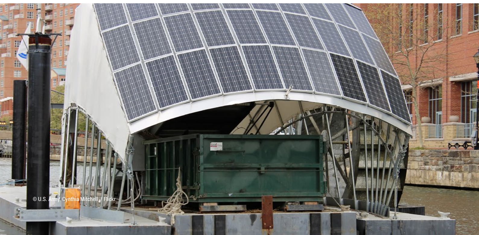
Figure 15: À Baltimore, États-Unis, la Inner Harbour Water Wheel, une roue à aubes installée dans le port de la ville conjugue anciennes et nouvelles technologies afin de collecter les déchets et les débris qui flottent le long de la rivière Jones Falls. Le courant fournit l'énergie hydraulique nécessaire pour actionner la roue à aubes, qui sort les déchets de l'eau et les dépose dans une barge. Lorsque le courant ne suffit pas, un ensemble de panneaux solaires fournit l'énergie supplémentaire nécessaire au fonctionnement de la machine. Lorsque la barge est pleine, elle est remorquée par bateau et remplacée.
