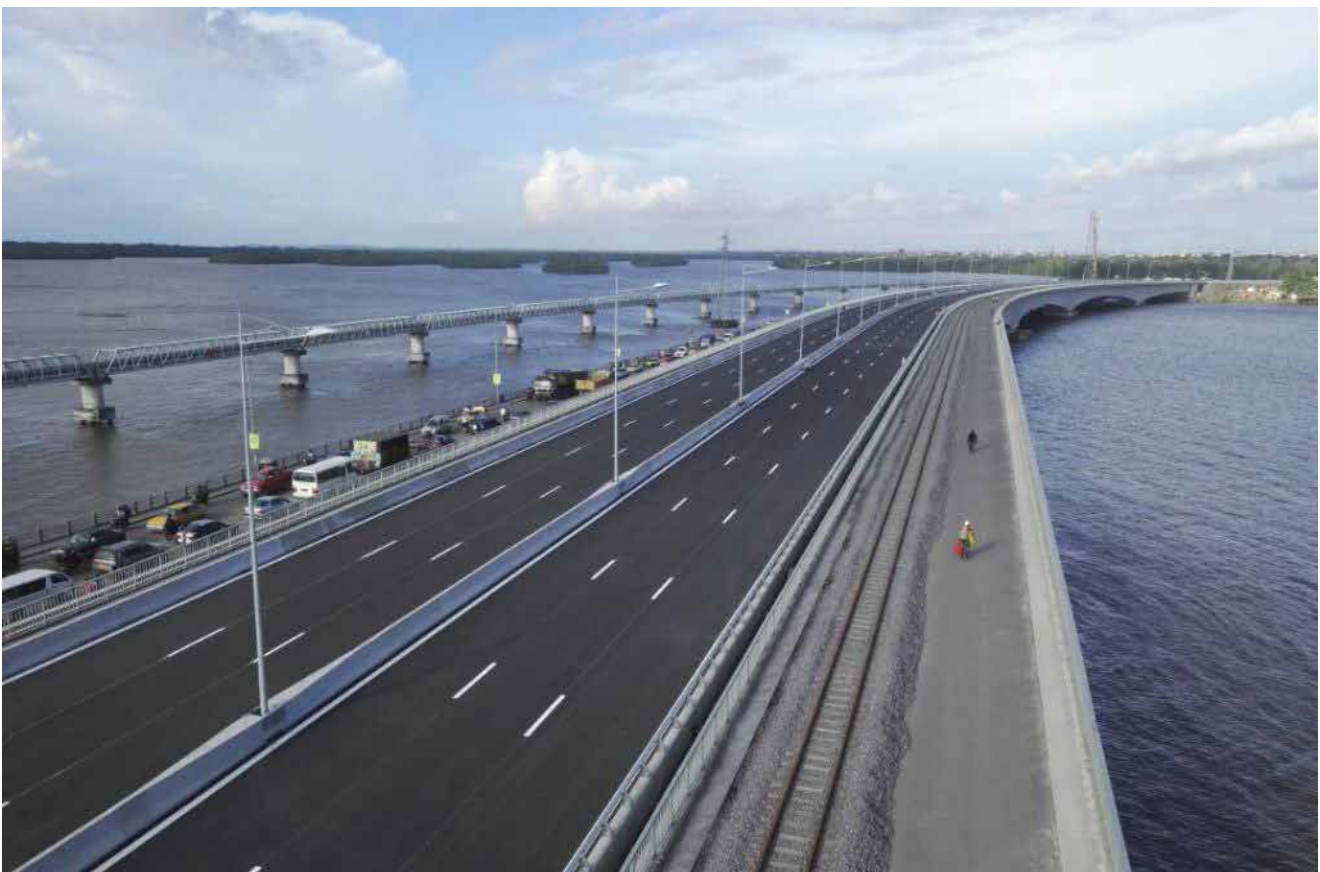
Photo 4. Deuxième pont sur la Rivière Wouri connectant Douala 4 au reste de la ville Source : http://photogame.prosygma-cm.com/Index.php/jeu/octobre/photo/nouveau_pont_sur_le_wouri_442
