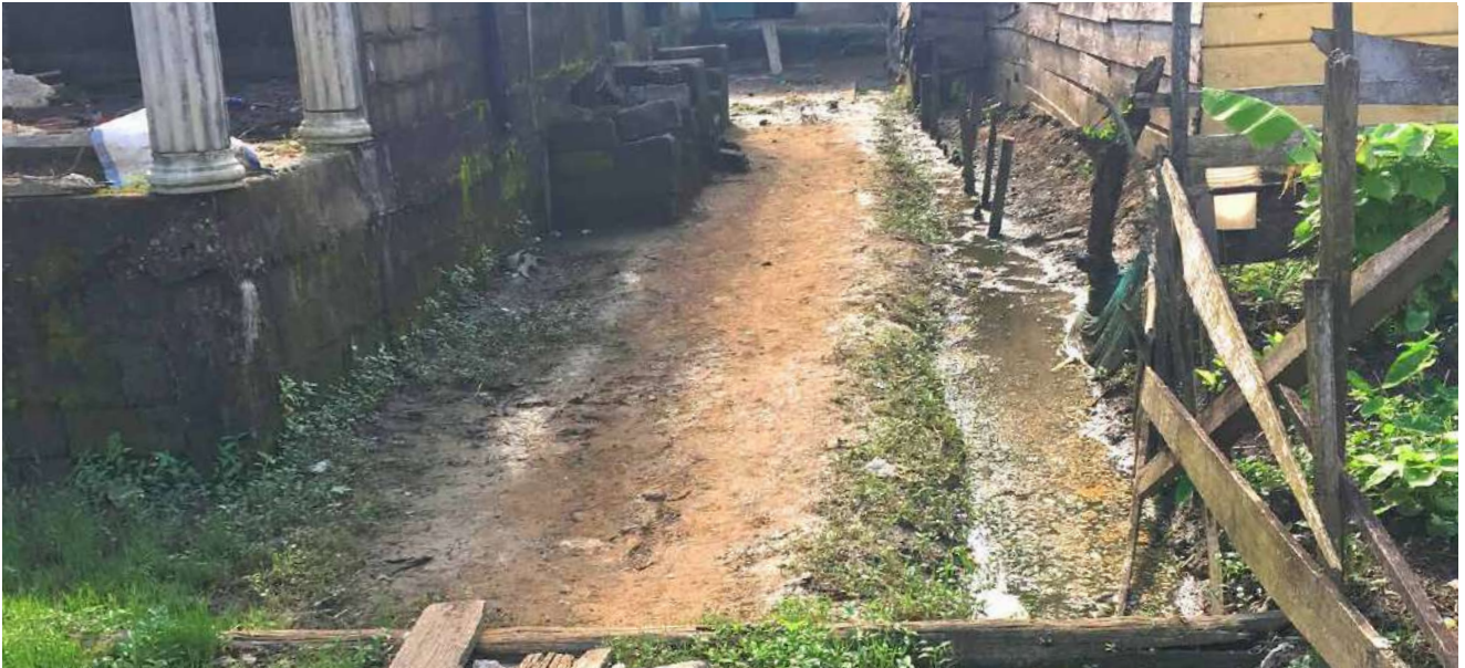
Photo 21. Entre les différents bâtis, des chemins de terre étroits ont été constitués afin de circuler Source : ONU-Habitat
