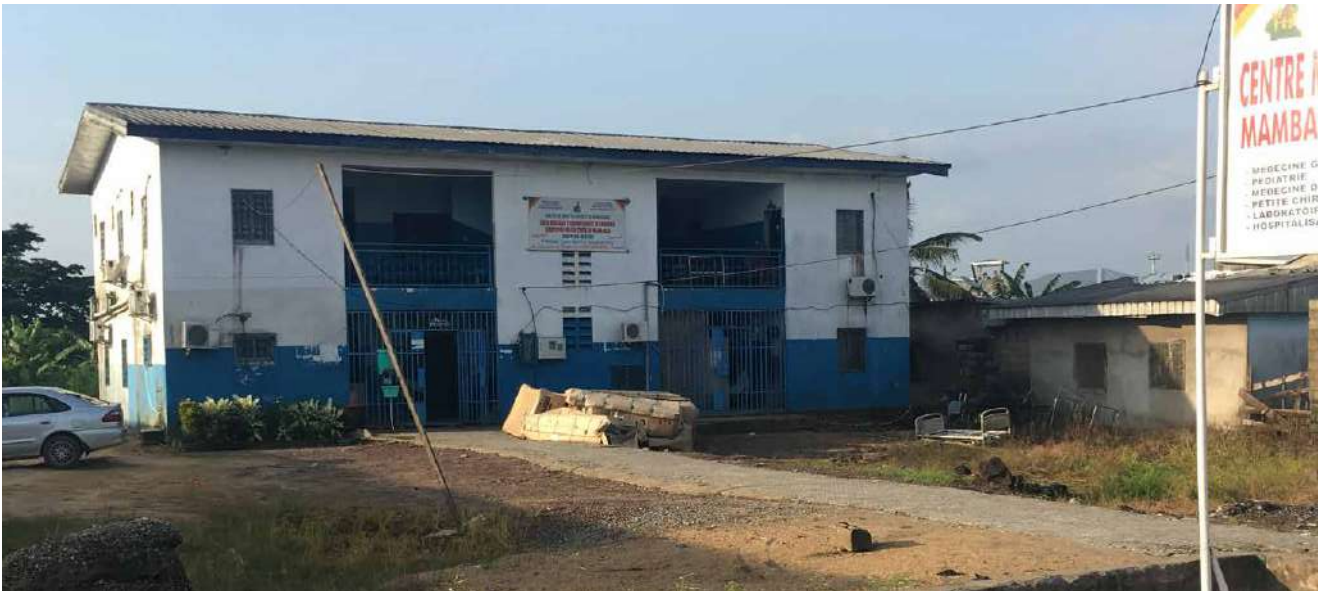
Photo 27. Le Centre de santé public de Mambanda Source : ONU-Habitat
