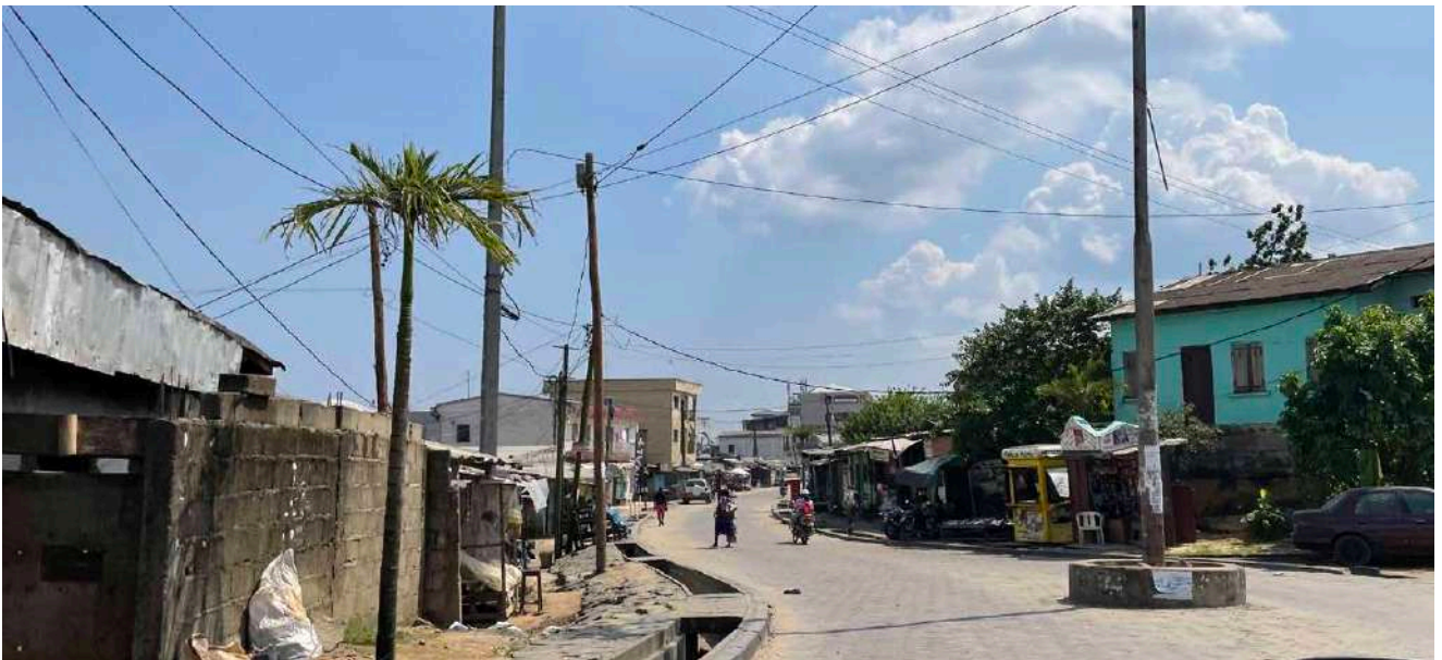
Photo 19. L'une des routes secondaires à Mambanda bitumée avec des pavés semi-perméables Source : ONU-Habitat
