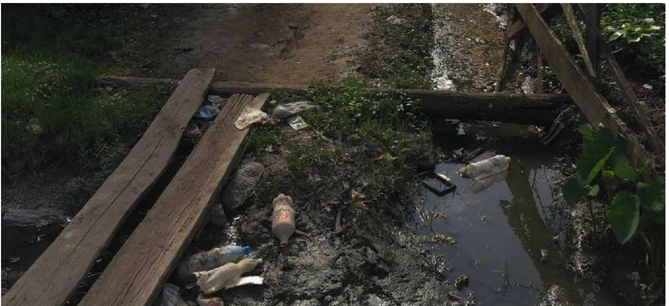
Photo 20. Planches de bois assemblées constituant des mini-ponts pour accéder aux maisons Source : ONU-Habitat
