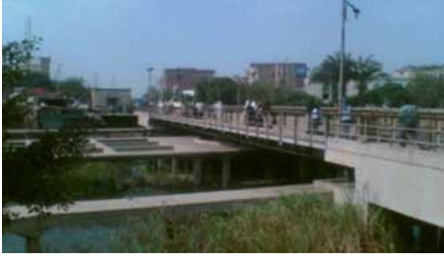
شكل (١٥): صورة توضح كوبري مشاه
