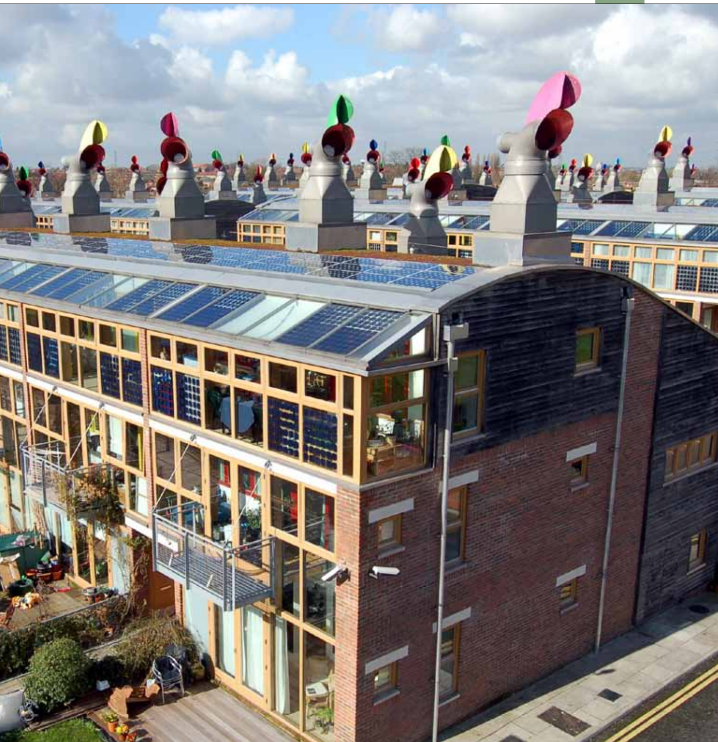
Ciudades y Cambio Climático – Área residencial de energía cero “The Beddington Zero fossil Energy Development” en el sur de Londres (Reino Unido) en un ejemplo de proyecto pionero por crear una comunidad sostenible donde a la gente le resulte fácil reducir su huella ecológica, utilizar energía solar y disfrutar de una buena calidad de vida.
