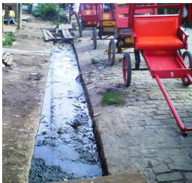
Canal d'évacuation non couvert et bouché, et un exemple de pousse-pousse.
