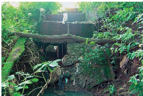
Figura 55 – Vista geral do córrego Ponta Porã
