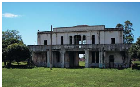
Figura 42 – Vista da fachada de fundos do prédio do Castelinho - 4º Batalhão da Polícia Militar de Ponta Porã
