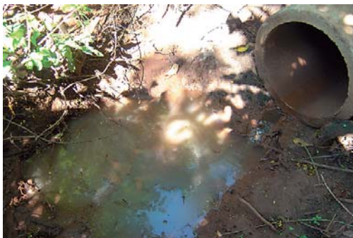
Figura 16 – Esgoto lançado nas nascentes
