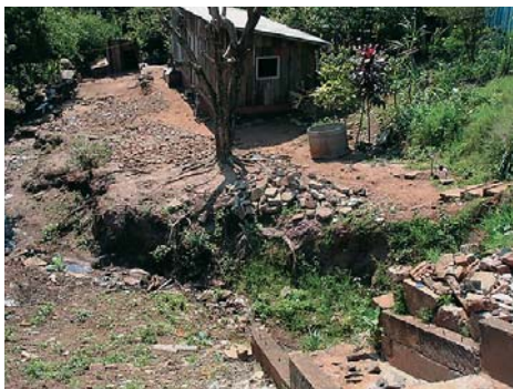
Figura 83 – Moradias em áreas de risco
