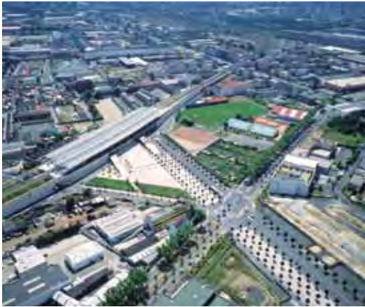
El megaproyecto de Plaine Saint-Denis en París ilustra la forma en que la infraestructura urbana se ha desarrollado en los últimos años © Gobry / DREIF
